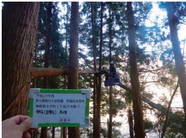
倒木(危険木)処理作業
