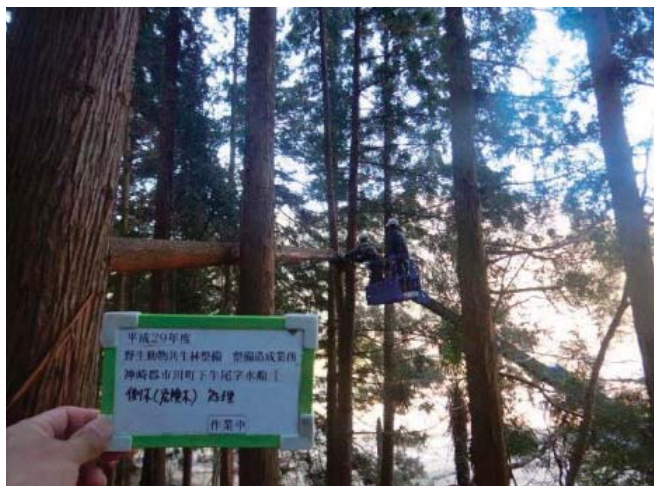
倒木(危険木)処理作業
