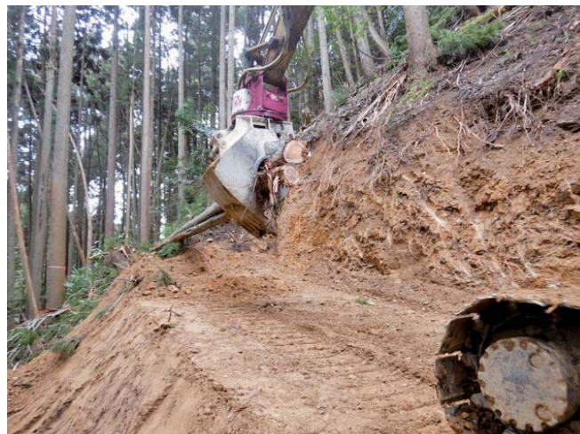
掘削・集材・切断が可能な フェラーバンチャーザウルスによる集材作業
