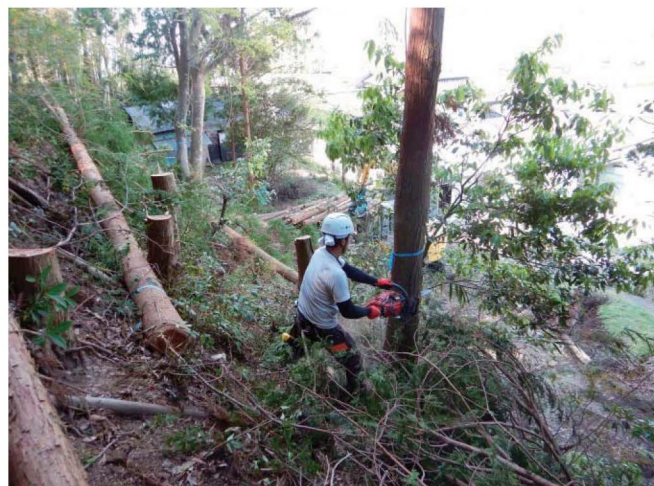
民家裏伐採状況
