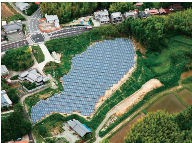
神戸市北区ソーラー発電所
