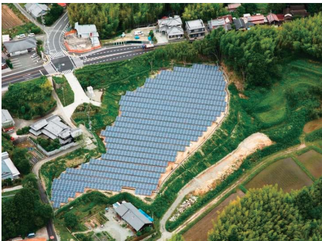
神戸市北区ソーラー発電所
