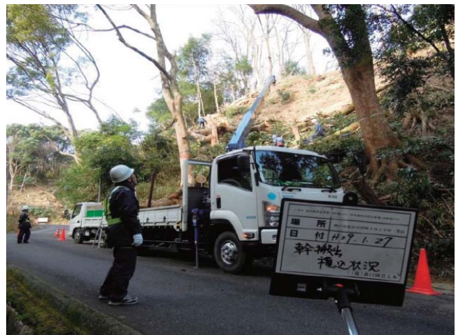
危険木伐採搬出作業
