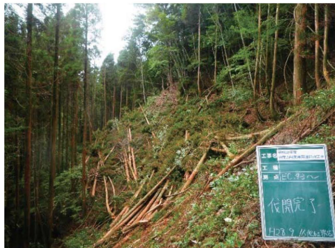
林道新設工事に伴う伐開
