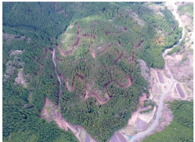
林内作業路の開設状況
