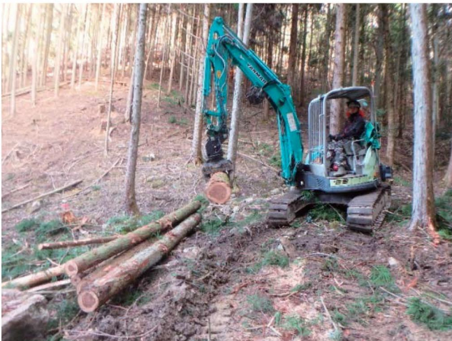
グラップルによる作業状況
