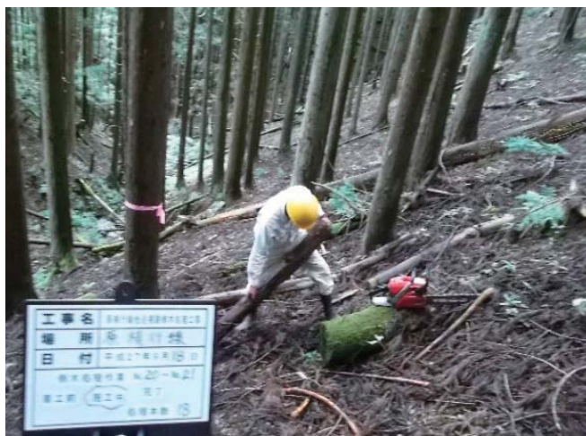
支障木の撤去作業
