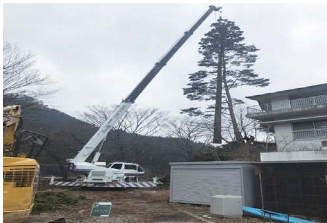
25tラフターによる特殊伐採
