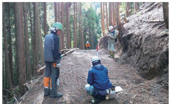
造林事業地での完成検査風景
