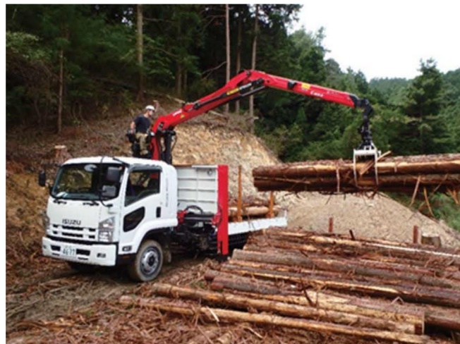
グラップル付トラックに材を積込中
