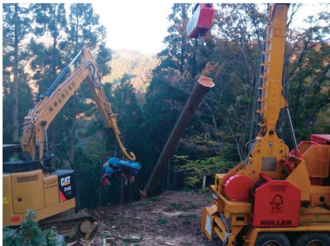
タワーヤダによる搬出作業
