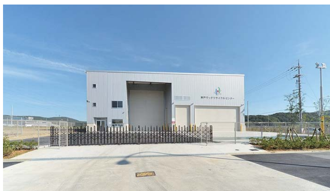
神戸ウッドリサイクルセンター
