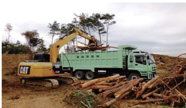
伐採後トラックに積込
