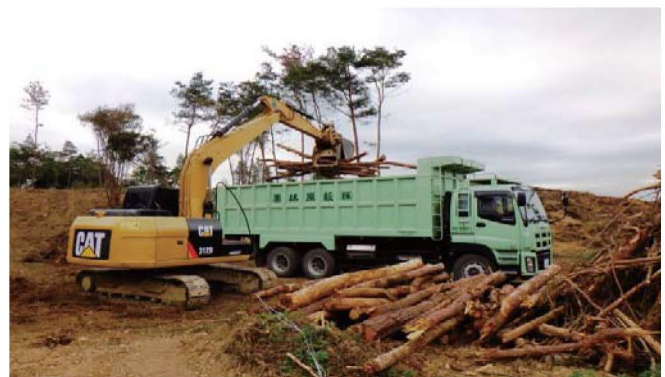
伐採後トラックに積込
