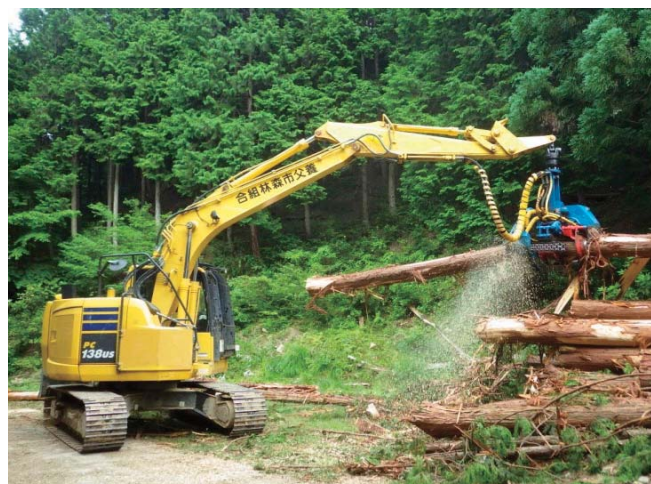
ハーベスタ稼働中
