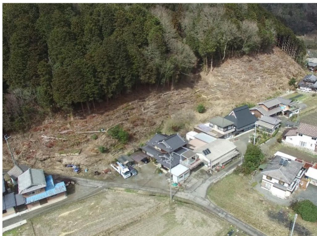
人家裏山の危険木伐倒後の状況
