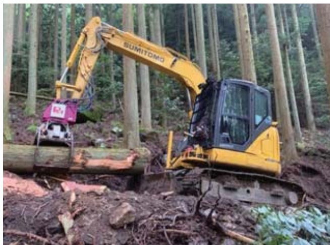
グラップルによる造材作業
