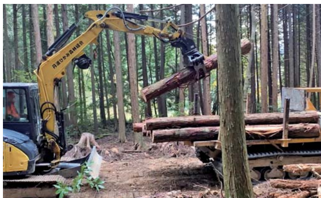
作業中のグラップル
