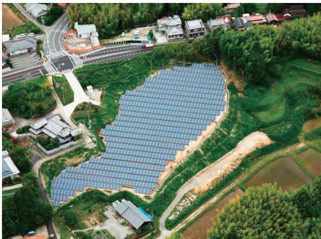
神戸市北区ソーラー発電所
