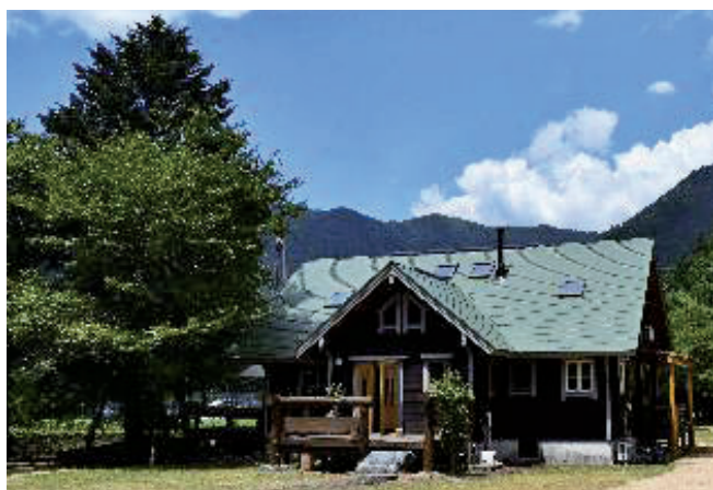
薪づくり等の林業体験もできるグリーンハウス・ジャスミン
