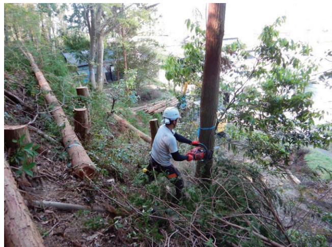
民家裏伐採状況
