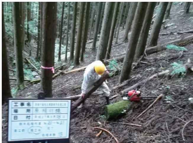
支障木の撤去作業
