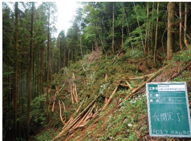
林道新設工事に伴う伐開
