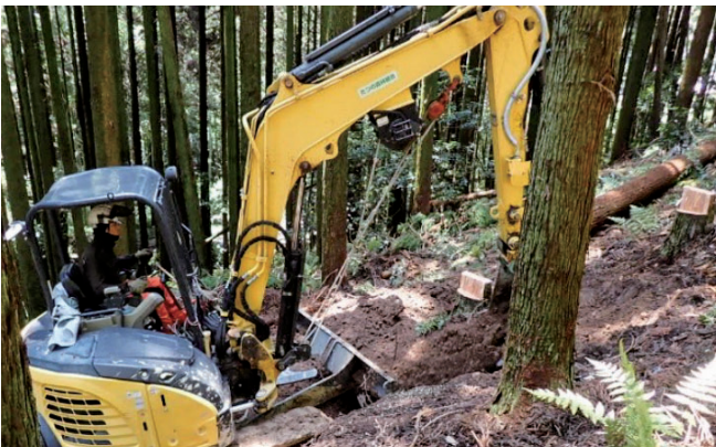
森林作業道の開設・素材生産
