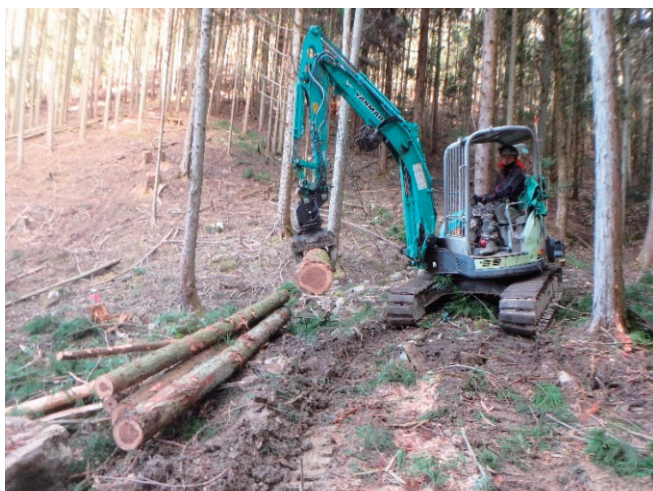
グラップルによる作業状況
