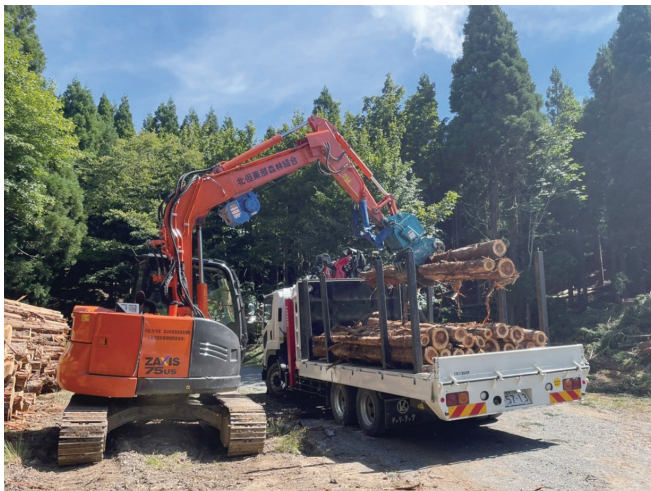
グラップルによる大型トラックへの積込作業状況
