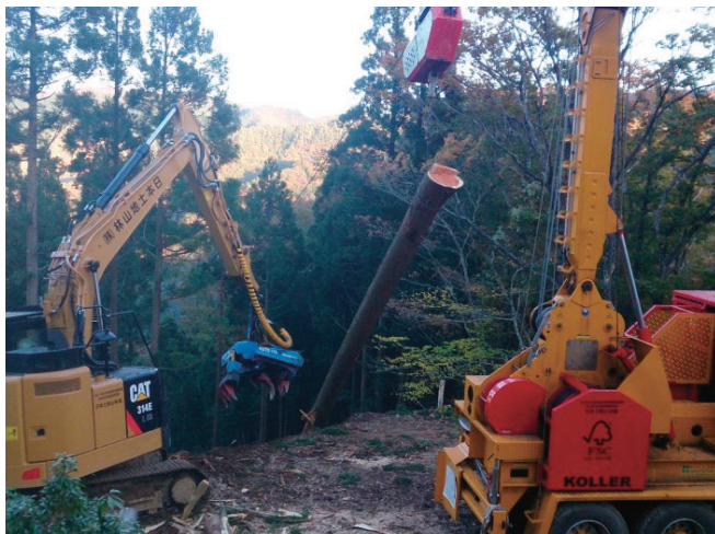
タワーヤダによる搬出作業
