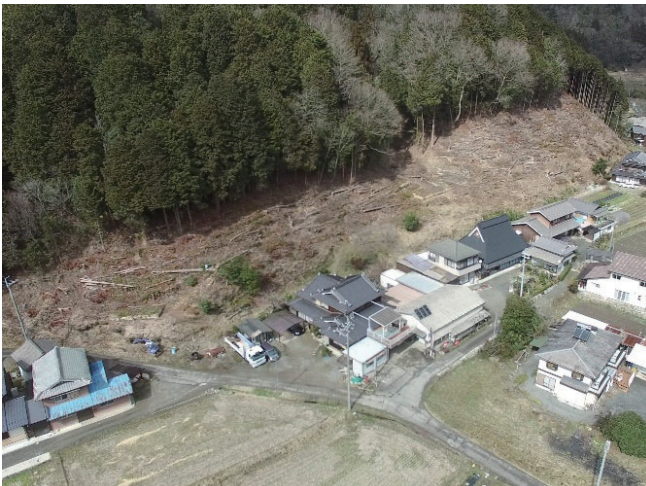
人家裏山の危険木伐倒後の状況
