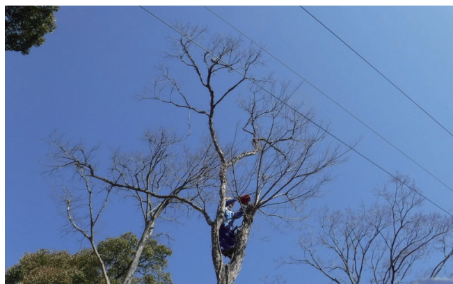
配電線の保安伐採状況
