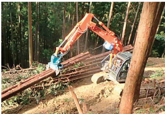
グラップルによる集材作業
