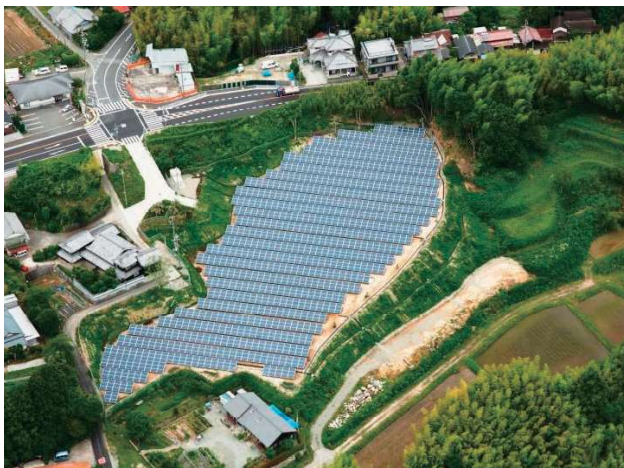
神戸市北区ソーラー発電所
