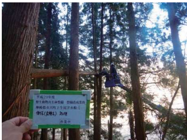
倒木(危険木)処理作業
