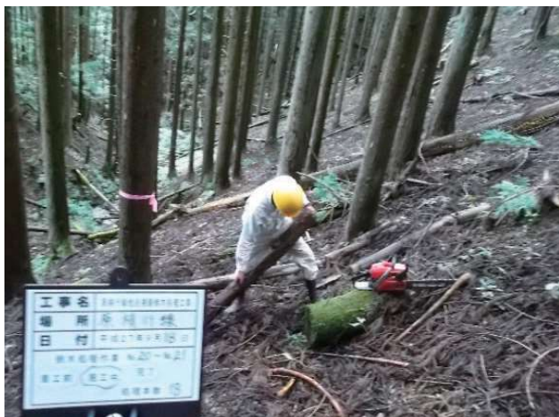
支障木の撤去作業
