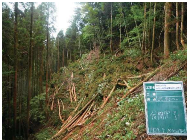
林道新設工事に伴う伐開
