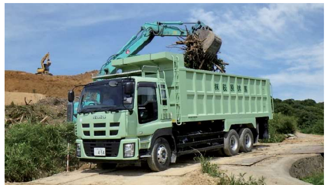
伐採後トラックに積込
