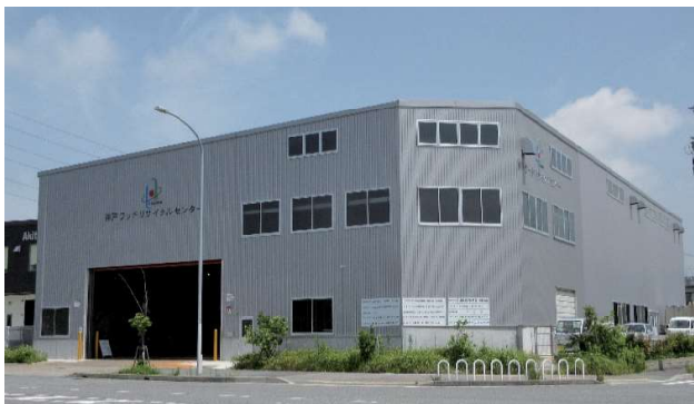
神戸ウッドリサイクルセンター
