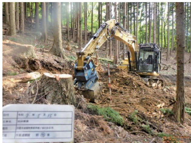
高性能林業機械による作業道の開設状況
