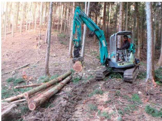
グラップルによる作業状況
