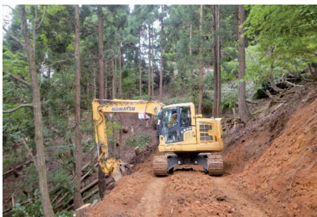
ザウルスロボによる作業道開設
